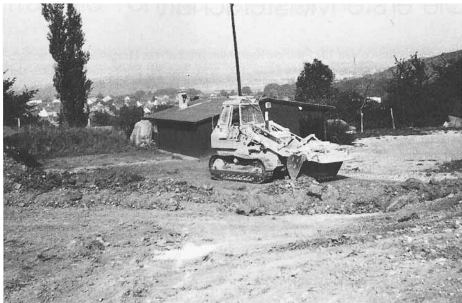
Vorbereitungen für die Erweiterung des Schützenhauses
