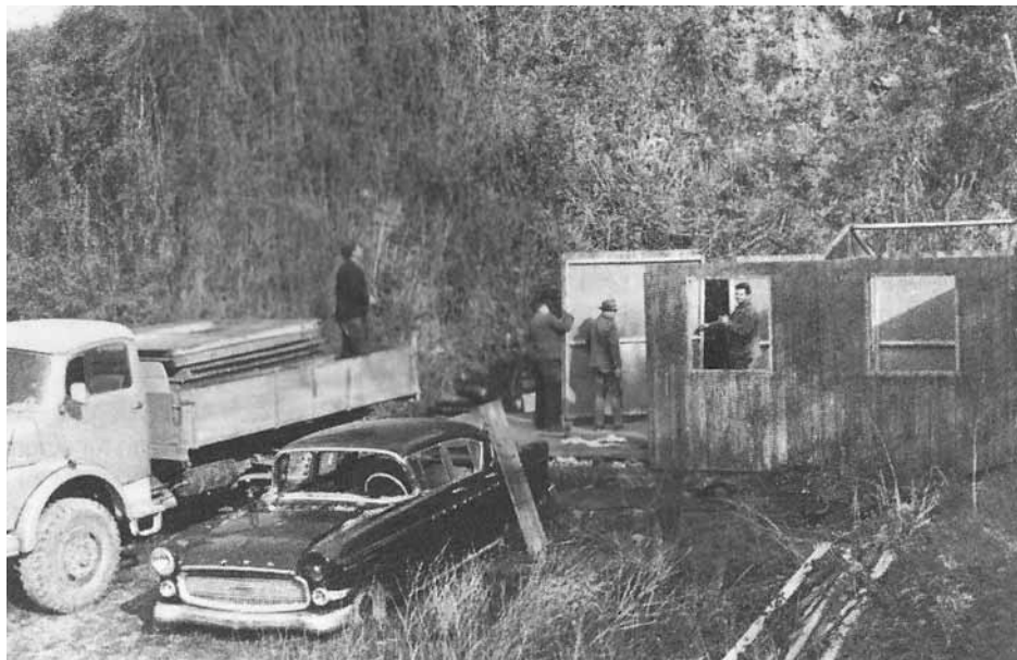
Abbruch der Vereinsheim-Baracke im Vaihinger Kehlweg
